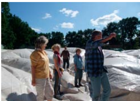
Noch liegt das Hallendach am Boden
