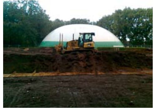
Die neue Halle vor der Traglufthalle
