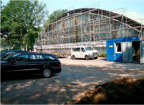
Endlich geht's los – das Hallenprojekt nimmt Form an
