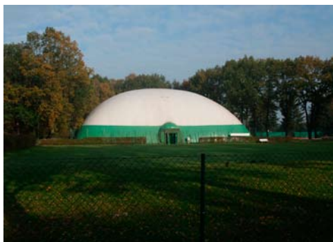
Um die alte Traglufthalle zu ersetzen
