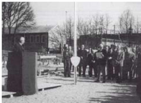
Grundsteinlegung am Marschweg
