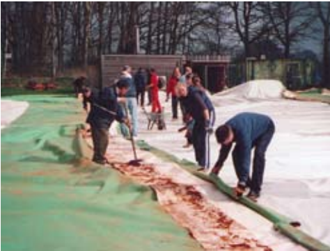
Viele fleißige Helferlein beim Abbau der Traglufthalle
